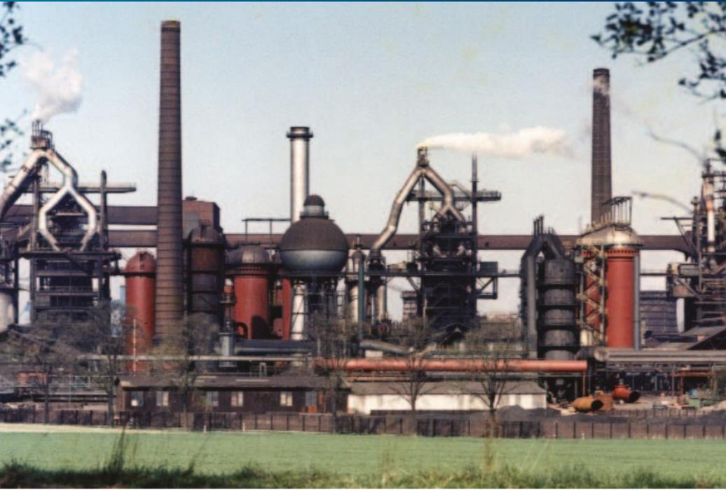
Das Bild zeigt die Situation des Hochofenbetriebes mit nur noch 3 Hochofen, den Öfen 3, 4 und 5, die seit 1965, mit Inbetriebnahme der Bandbegichtungsanlage die Roheisenproduktion sicherstellten. In der letzten Ausbaustufe mit den leistungsfähigen Nebenanlagen, wie Winderzeugung, Winderhitzer, der Bandbegichtung und der Sinteranlage erzeugten sie ab 1973 eine Monatsleistung von 150.000 t Roheisen.
