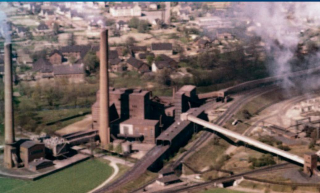
Die Größe einer Anlage ergibt sich aus der Saugfläche des Rostbandes. In der Sinteranlage wurde ein hervorragender Sintermüller mit 55 Prozent Eisenanteil erzeugt. Bei dem hohen Sinteranteil im Hochofenmüller war dies entscheidend für den wirtschaftlichen Betrieb der Hochöfen.
