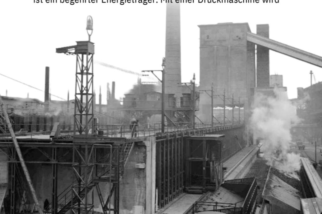
der durchgarte, glühende Koks nach Öffnen der Kammertüren aus der Ofenkammer durch einen Kokskuchenführungswagen auf den Kokslöschwagen gedrückt – siehe Station 12, Kokslöschwagen. Danach wurden die Türdichtflächen der Ofenkammer gereinigt und die Türen wieder verschlossen. Die Kammer wurde wieder mit Kohle befüllt, der Prozess begann von Neuem. Ein sog. Türrahmen, der hier aufgestellt ist, vermittelt die Größe einer „Kammeröffnung“.
