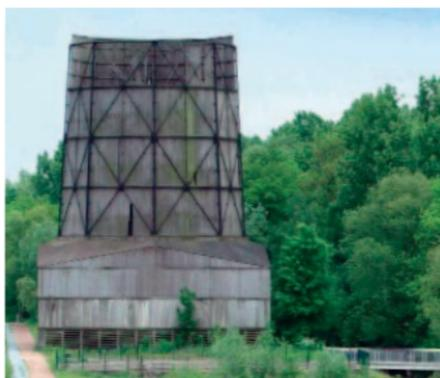
Kühltürme schaffen je nach Wetterlage eine Kühlleistung von bis zu 10°C Differenz im Wasser. Auf dem Hochofenwerk waren zwölf Kühltürme in Betrieb.
