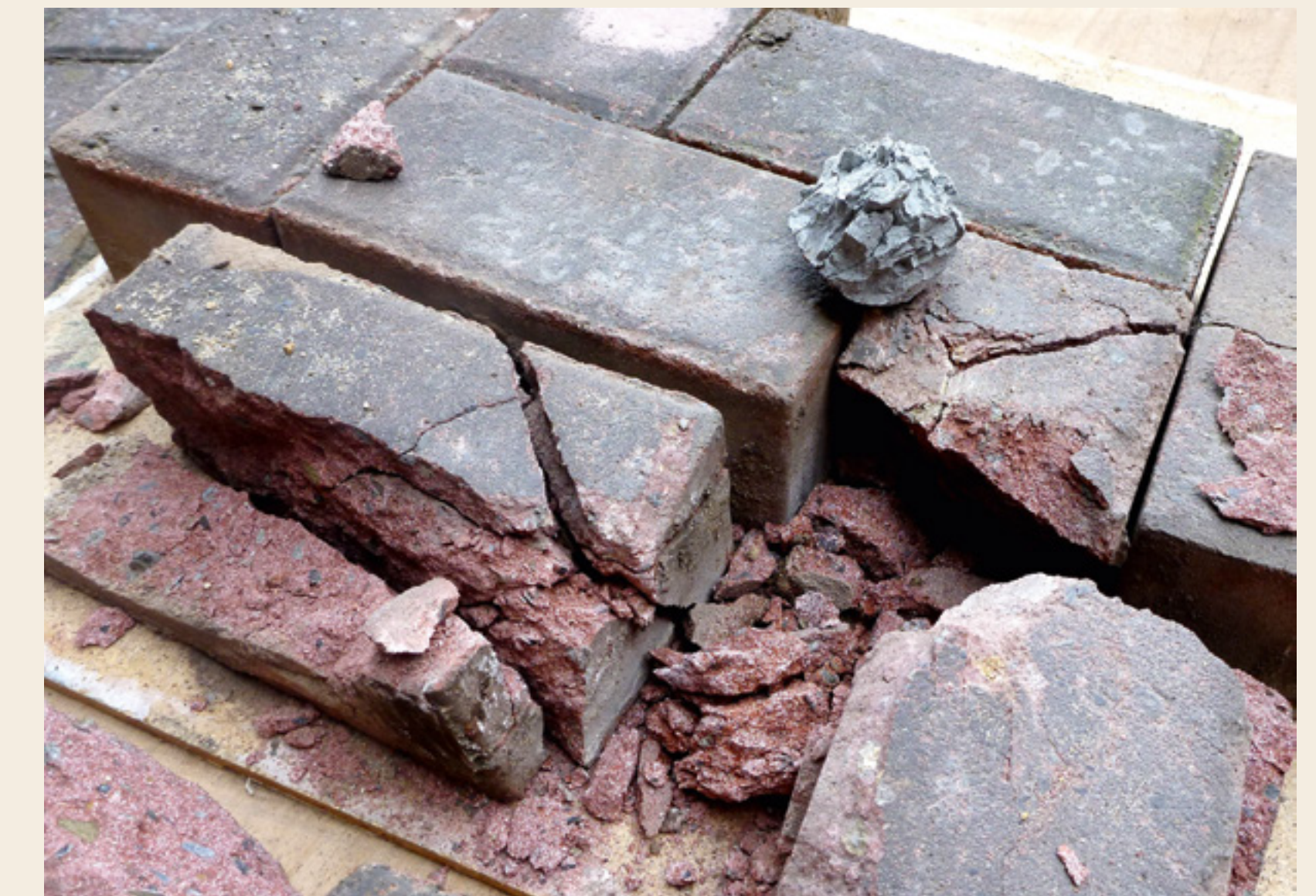
Abb. 4: Zerstörung des Beton-Pflasters (Foto: R. Bartoschewitz)
